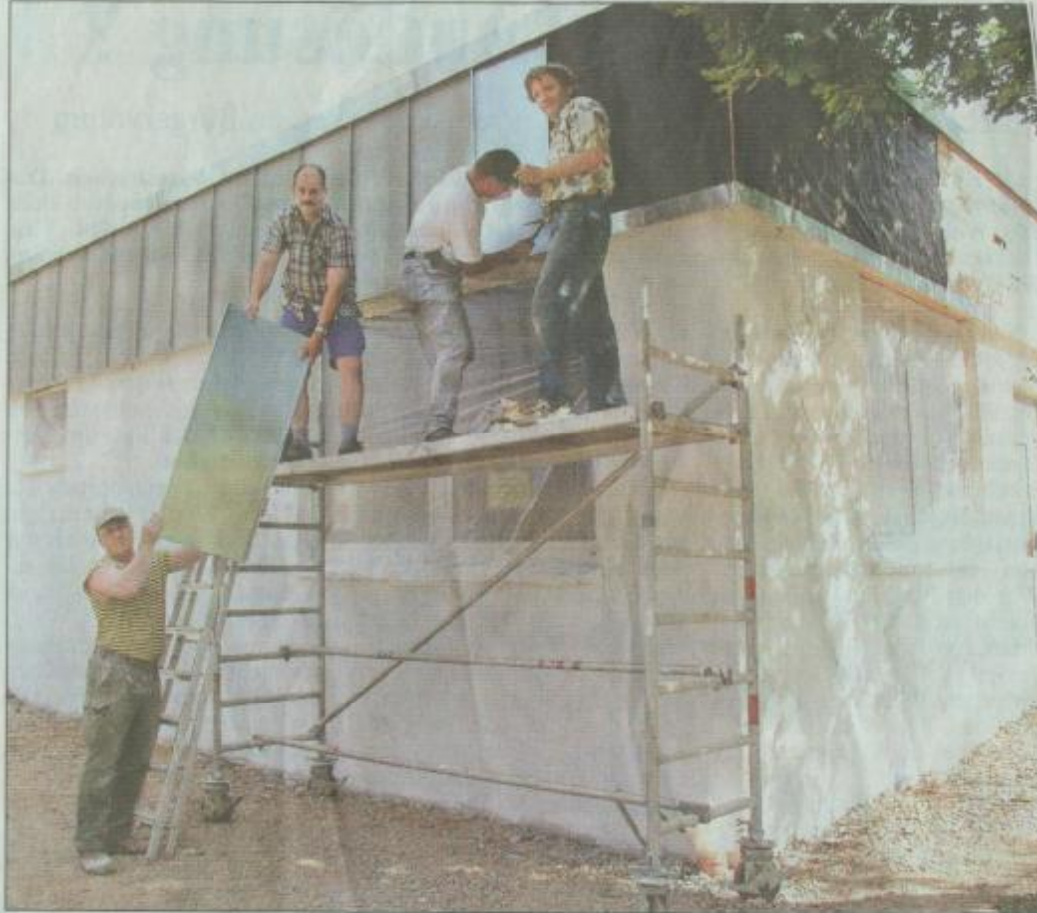
Das Kelterhaus des Obst- und Gartenbauverein Strinz-Margarethä an der Aubachhalle geht seiner Vollendung entgegen. Gebaut wird es ausschließlich in Eigenleistung von Mitgliedern und Helfer des Vereins, seit August 2001 sind sie hier im Einsatz. Am 29. September diesen Jahres soll im Rahmen des Kelterfestes die Einweihung gefeiert werden. Bild: wita/Martin Fromme
